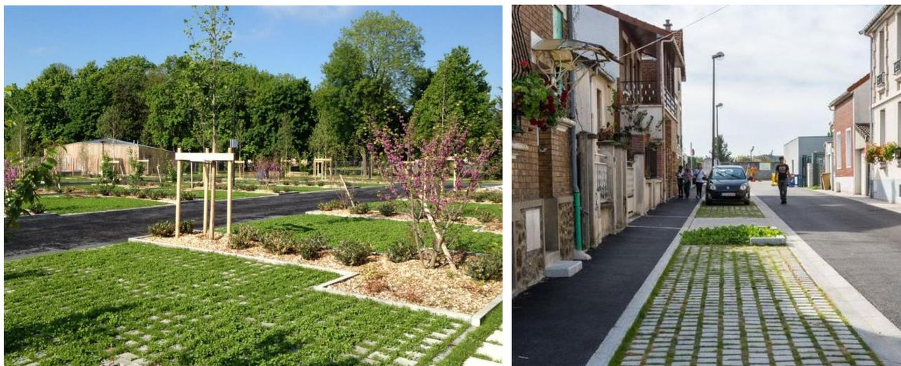
Exemple de revêtement perméable pour le stationnement : pavés béton avec joint enherbés
